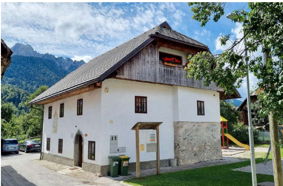
Kajžnkova hiša s severne strani, kjer se vidi po obnovi še ohranjena stena. Fotografija je iz leta 2022.
