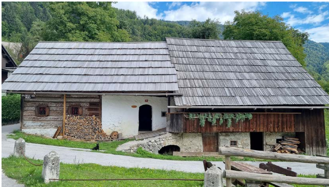
Domačija je sestav dveh zgradb, ki se spajata pod rahlim kotom: levo je stanovanjski, desno pa gospodarski del. Fotografija je iz leta 2022.
