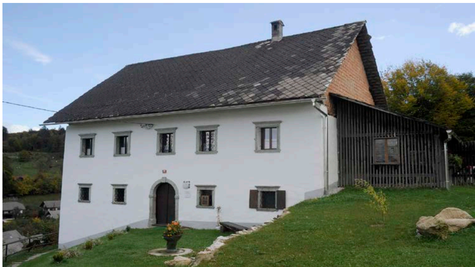
Mežnarija je velika nadstropna zgradba, ki stoji na robu platoja, pravokotno na plastnice. Fotografija je iz leta 2015.
