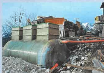
Čistilna naprava pred zasutjem
