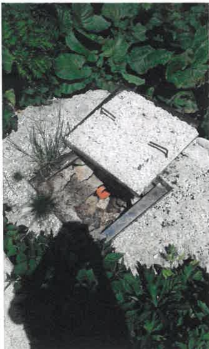
Slika 2: Ponikovalnica čistilne naprave
