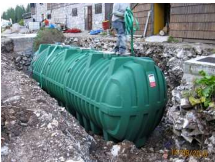
Slika 1: Vgradnja MKČN ob Koči pri Triglavskih jezerih
