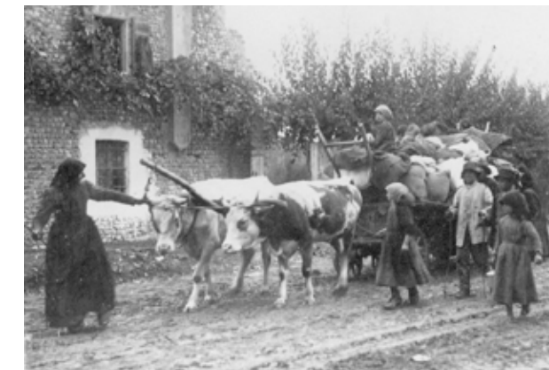
BEGUNCI S SOŠKE FRONTE
