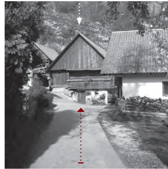
Najnižja točka na horizontu, sleme gospodarskega poslopja ter vhod v spodnji del so v osi dostopne poti.
