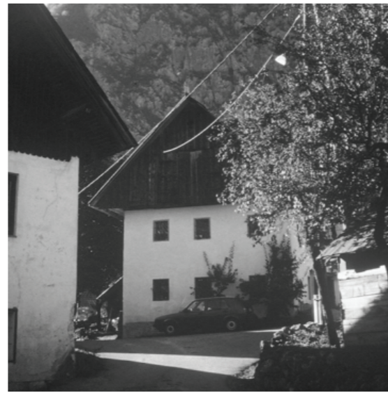
Hišno pročelje v osi prehoda navzgor v Studorju.
