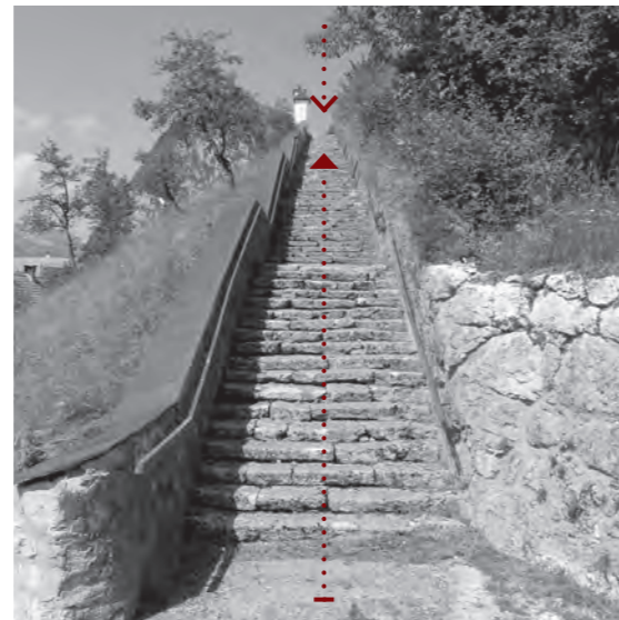
Zgornji del stopnišča do cerkve v Srednji vasi se usmerja na prelaz med Studirjem in Pokljuko.
