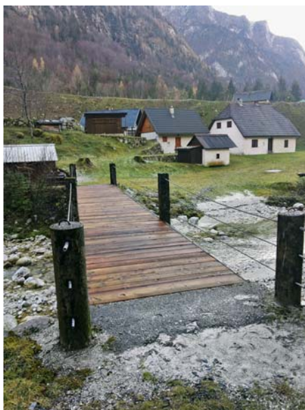
ZGORAJ: OBNOVLJENA RUTARJEVA BRV ČEZ SOČO
