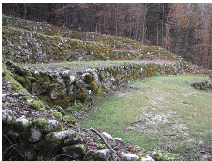
DESNO: KAŠTE V LEPENI SPODA: GRADNJA NA SUHO NA PLANINI USKOVNICA OKOLI LETA 1960
