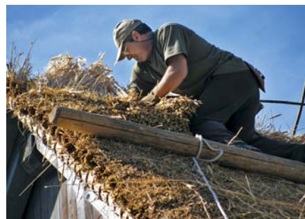
Slavko Šorli, sedanji gospodar pri delu na novi slamnati strehi V Tolminskih Ravnah
