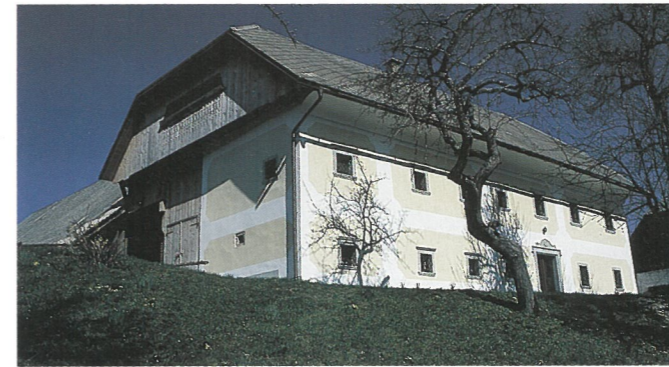
Stanovanjska hiša Zgornje Laze 20 - Krničarjev dvorec pred obnovo in po njej. Hišo so razglasili za kulturni spomenik.
