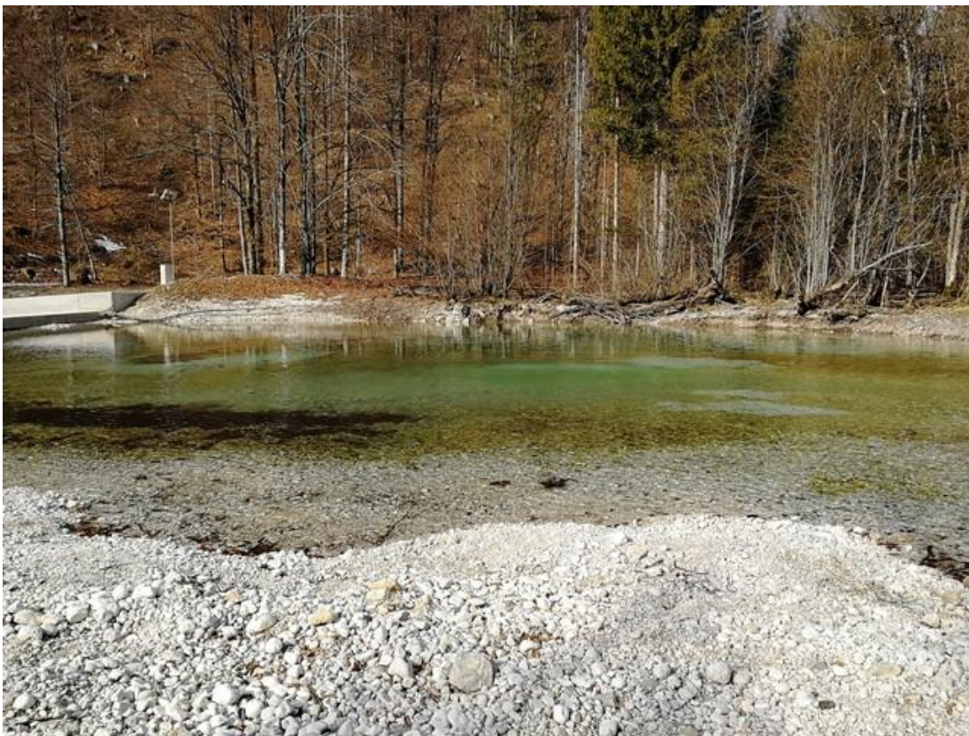
Slika 2: Desna brežina reke Radovne ob jezu dne 29.3.2022 (arhiv JZ TNP)
